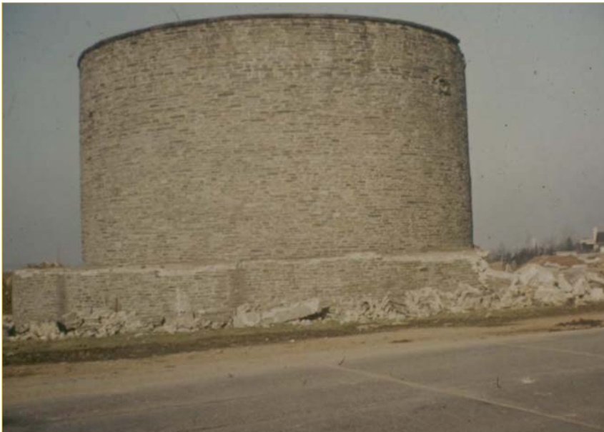
Blick von Süden, im Vordergrund die Panzerstraße
