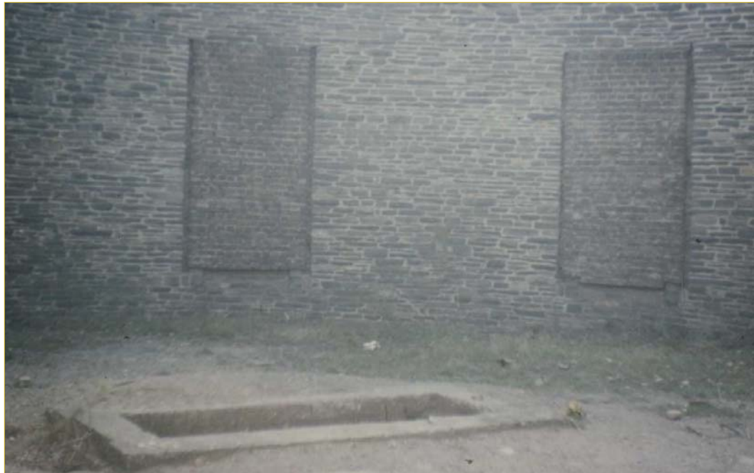
Blick vom Eingang auf die innere Wand, 2 der 8 Ziegelflächen von 1,5 X 2,5 m auf denen die Tafeln mit den Namen der Gefallenen angebracht werden sollten.
